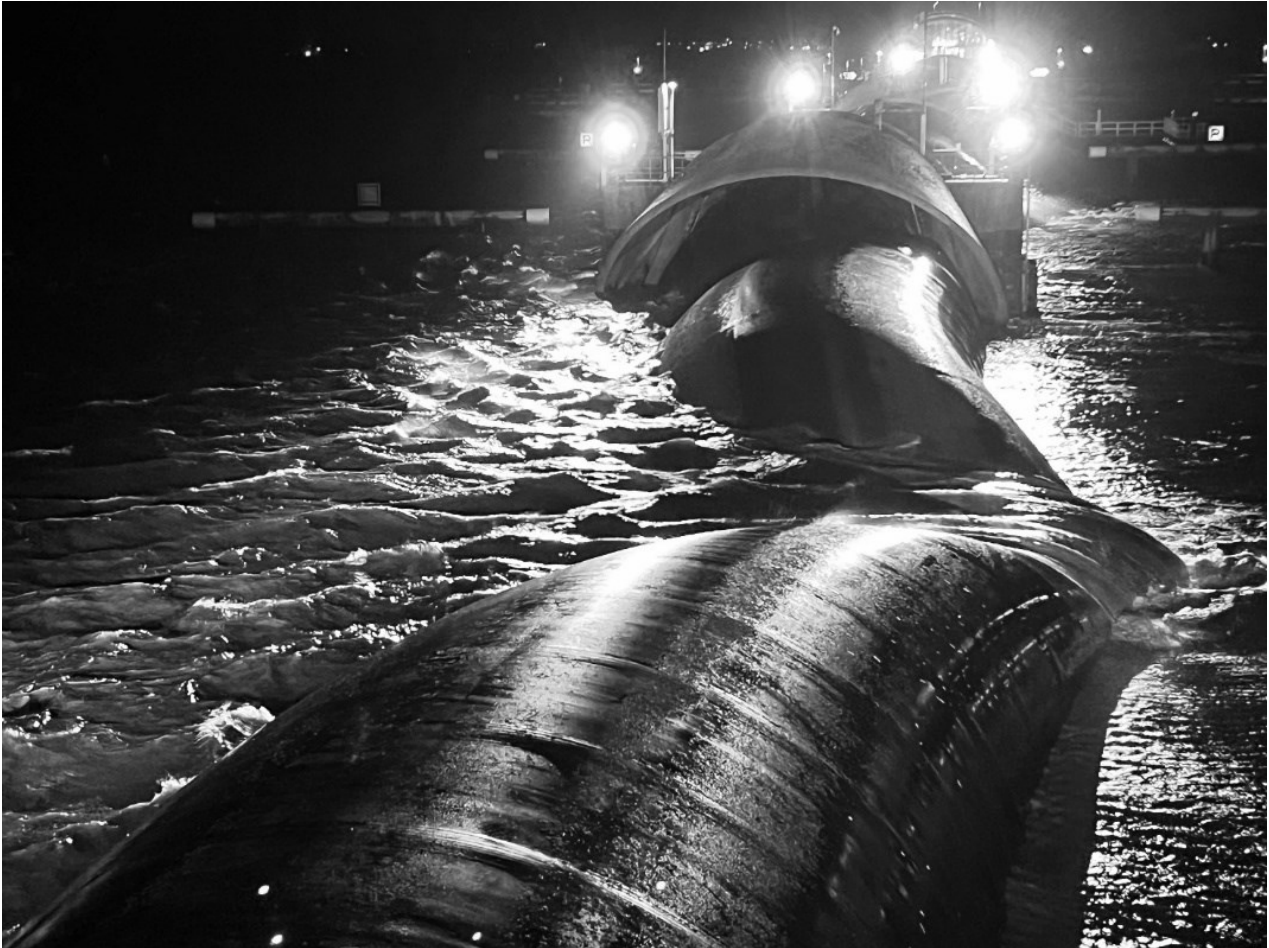
Figuur 14 De balgstuw van de Ramspolkering in bijna gesloten toestand met een waterstand van + 1,20 m NAP voor de kering (links) en - 0,05 m NAP aan de achterzijde (rechts). Foto door Gwen Kleijn van Willigen-Plantenberg.
